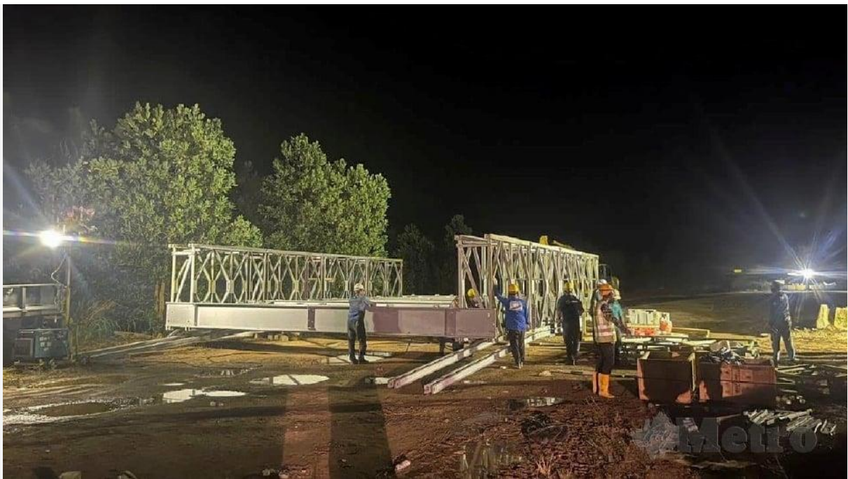
Jambatan bailey di Seksyen 102, Jalan Kuantan-Segamat (FT012).
