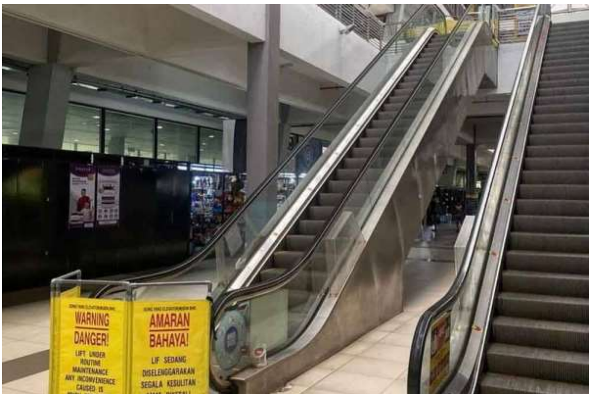
TSK menutup laluan eskalator buat sementara waktu bagi proses pembaikan handrail.
