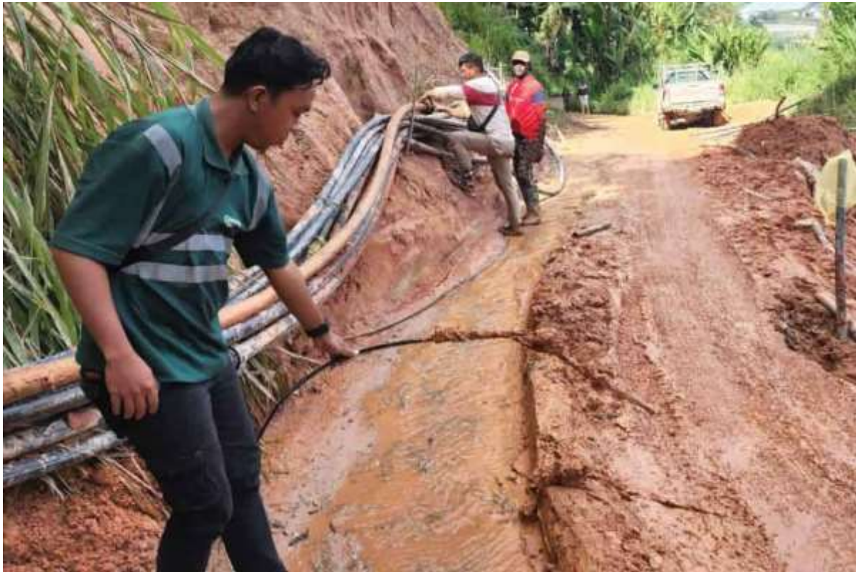
Kerja penyambungan kabel yang terputus di beberapa lokasi itu selesai dilakukan pagi tadi. - Foto Facebook Fadzli Kamal
