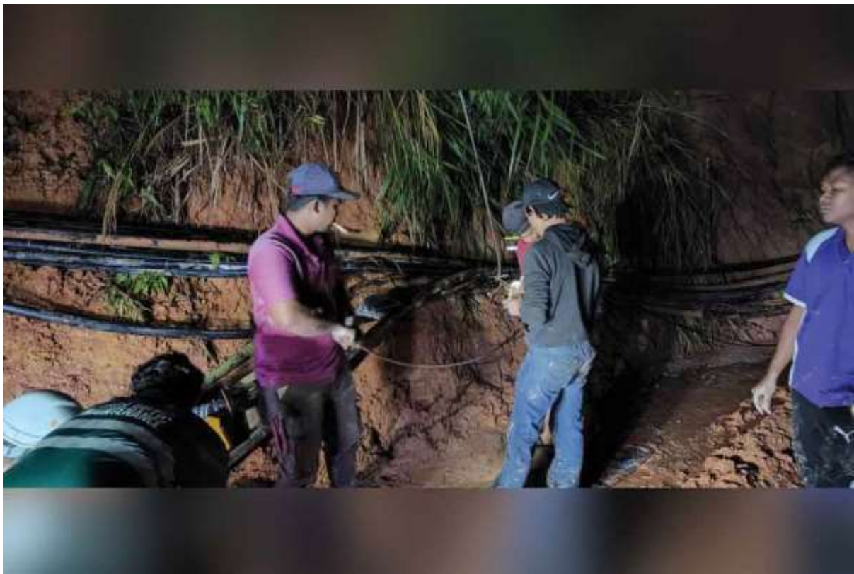
Kabel gentian optik terputus akibat tanah runtuh pada Rabu lepas, pulih sepenuhnya pada Isnin. - Foto Facebook Fadzli Kamal
