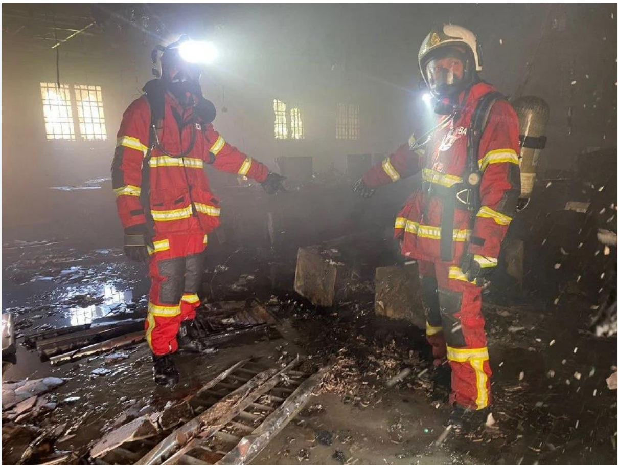
Anggota bomba menunjukkan keadaan makmal komputer yang musnah dijilat api dalam kebakaran di Kampus Kejuruteraan Universiti Sains Malaysia (USM) hari ini. - Foto ihsan PGO JBPM Pulau Pinang
