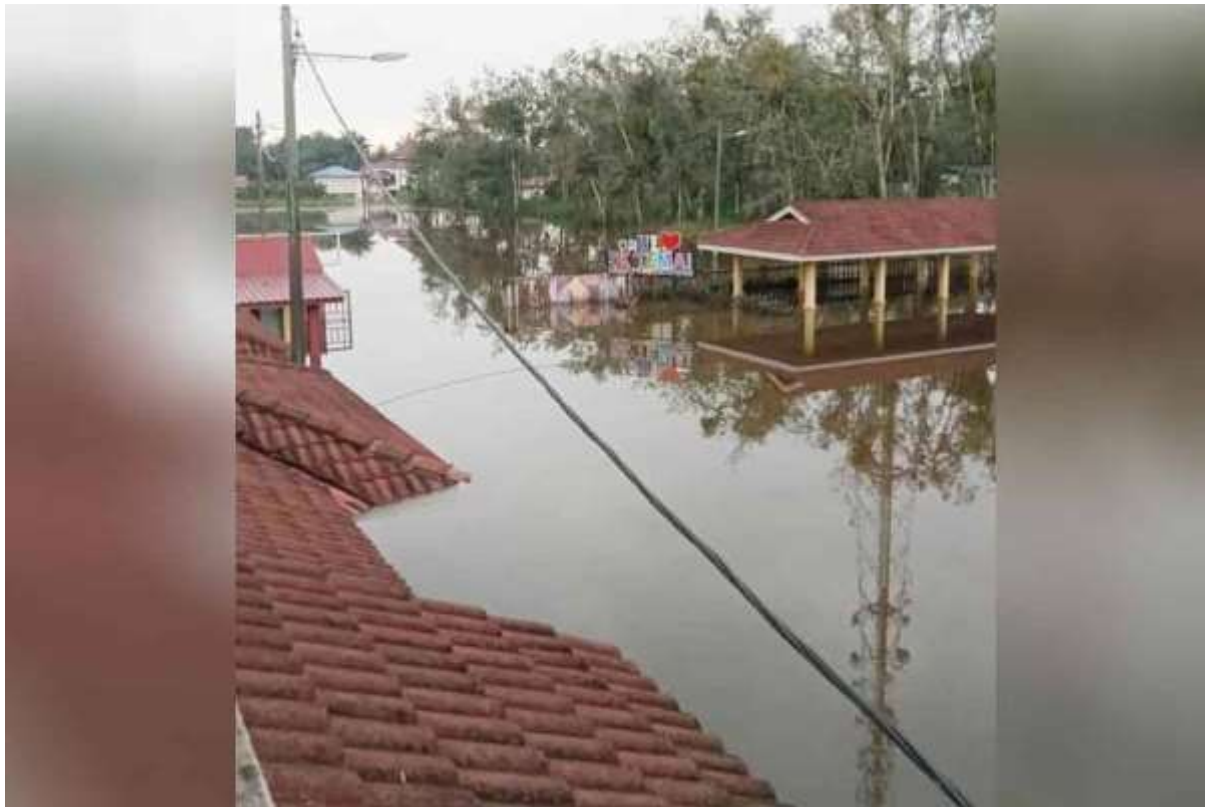
Sk Temai masih ditenggelami air banjir sedalam 0.8 meter.
