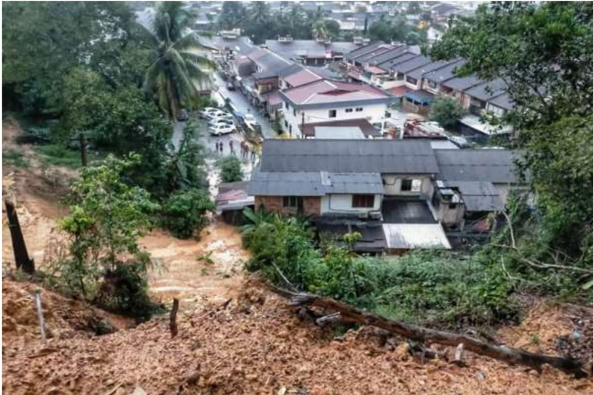
Kejadian tanah runtuh di Taman Lipis Fasa 2 pada Jumaat menyebabkan dua penghuni diarahkan berpindah. - Foto Ihsan JBPM
