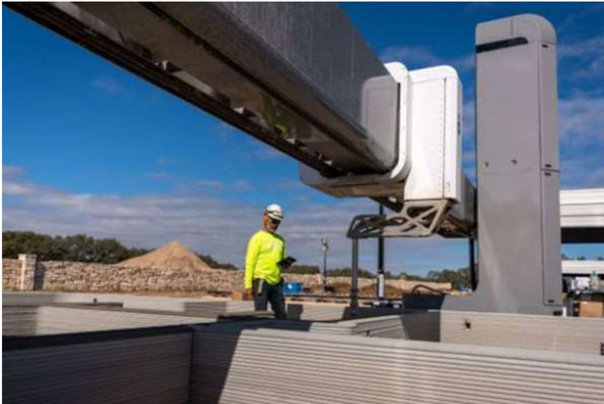
Pembinaan struktur menggunakan pencetakan 3D memerlukan mesin pencetak besar yang diprogramkan dengan maklumat reka bentuk.
