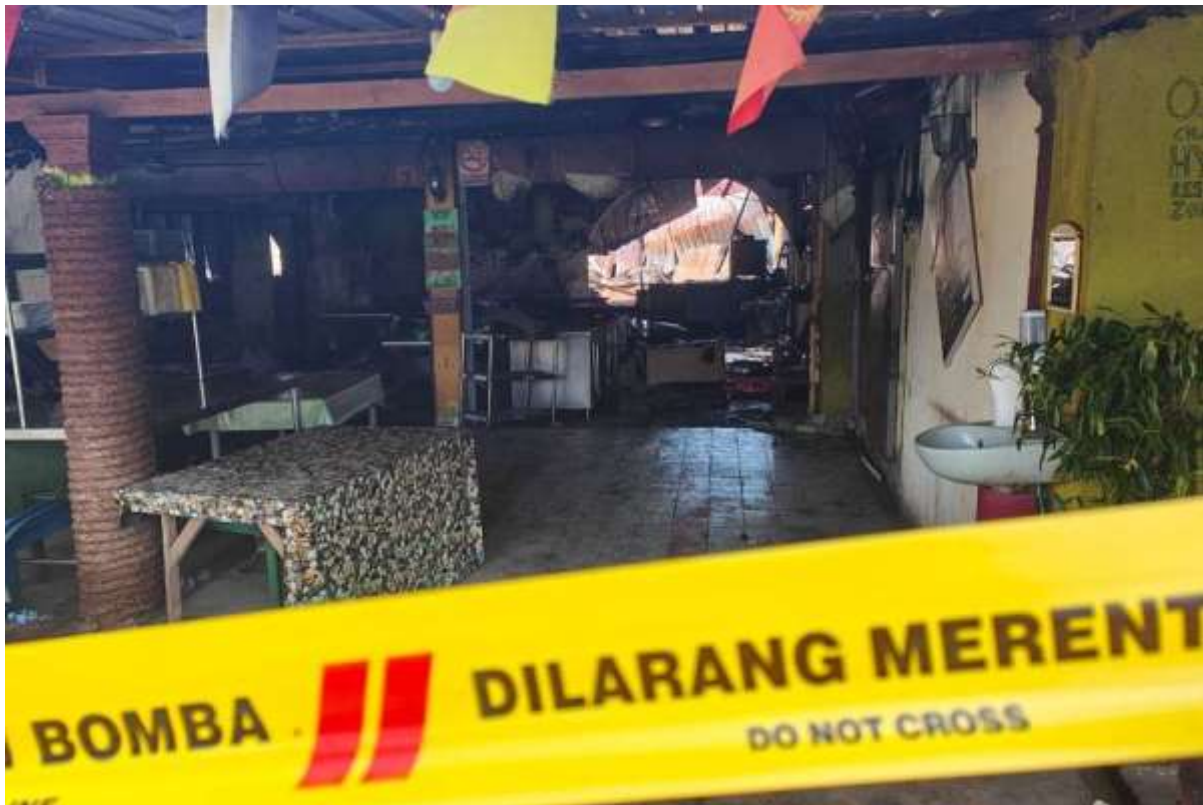
Keadaan kedai Rosleda yang terbakar pada Khamis
