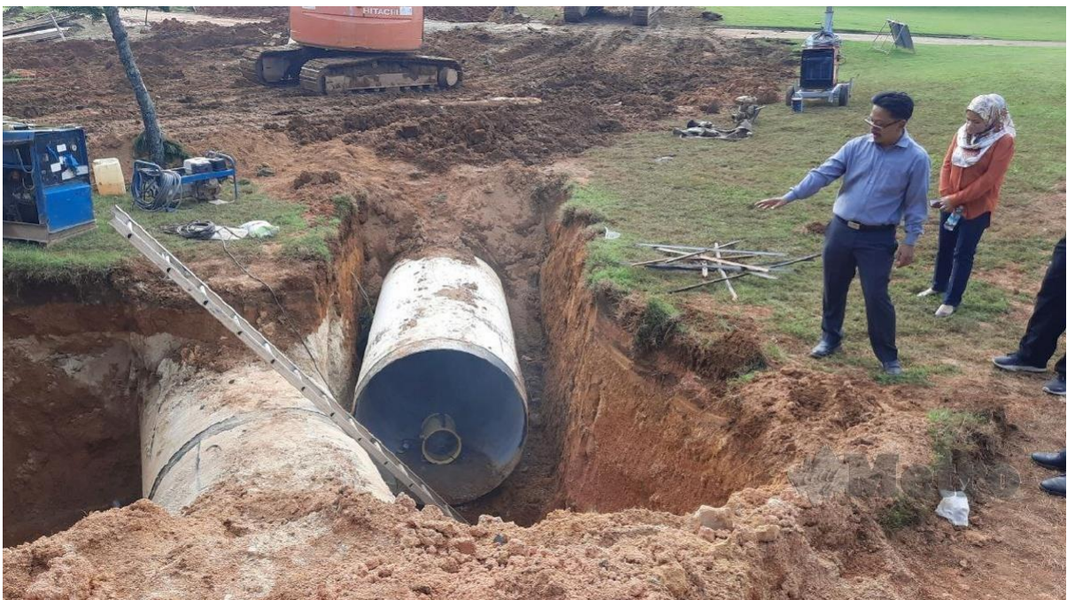
SAIFUL Zaini meninjau kerja pemasangan paip baharu di MGCC, Kuantan. FOTO Asrol Awang
