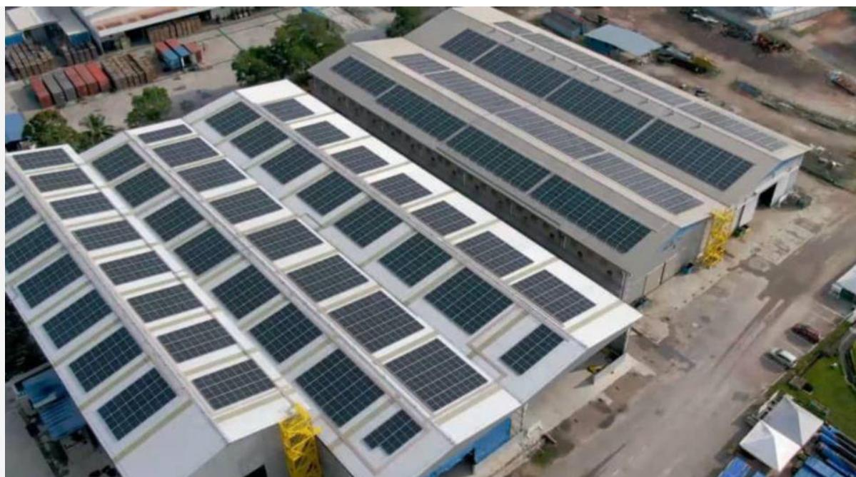
Pemasangan solar bumbung berkapasiti 8.3 megawatt puncak (MWp) di MMHE West - Foto MHB
